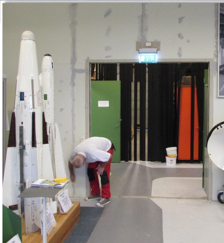
Rolf Jarl slipar på den spacklade väggen för att sen kunna måla.
